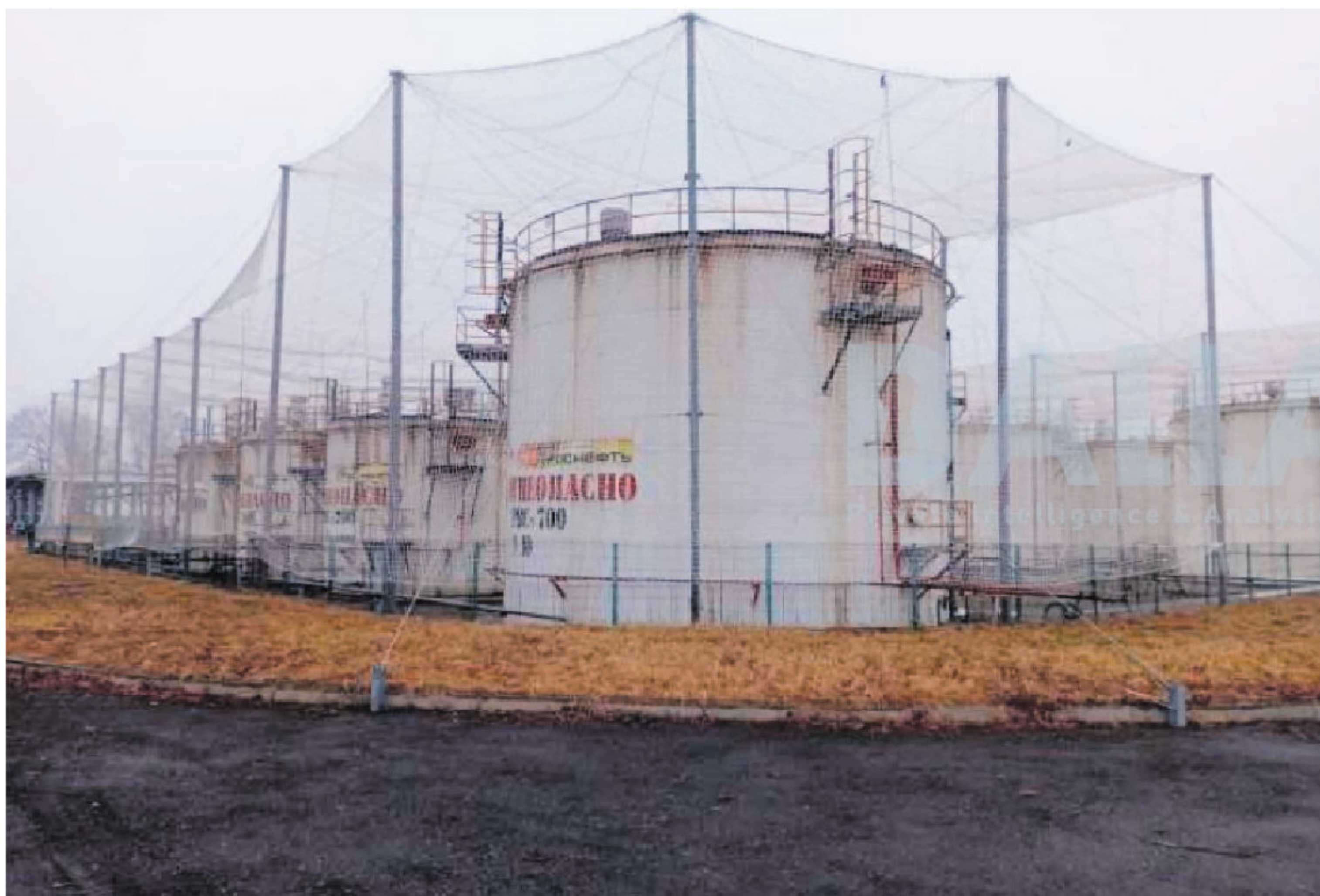
Depósitos de petróleo protegidos con mallas antidrones, en una imagen del informe de Rosneft de 2026, obtenido por Dallas Analytics.
